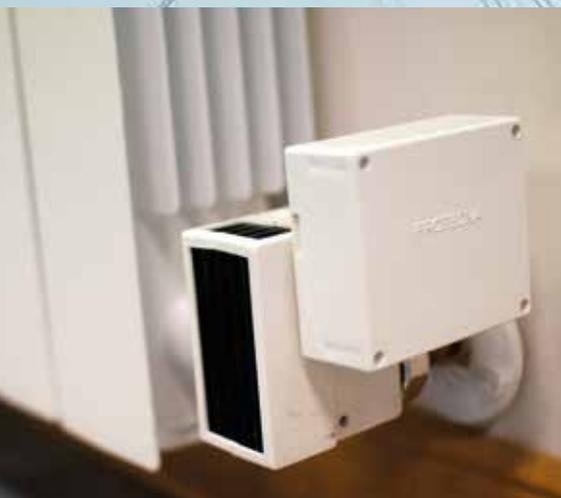
Sistema de zonificación de la instalación de calefacción del centro pudiendo programar horarios y temperatura por espacios y usos, válido para una instalación existente, y alimentándose mediante las células Petier, evitando el cableado de alimentación, y de comunicación utilizando radiofrecuencia.
