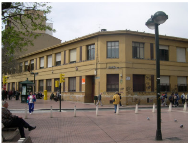
Fachada principal del colegio
