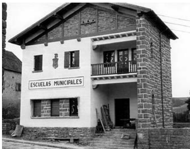
Escuelas Municipales de Niñas y vivienda para la maestra de Garralda construida en 1957. Fotografía cedida por Acciona Garraldako Udala.
