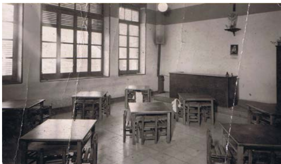
Interior del aula de párvulos de Uharte Arakil. 1957.
