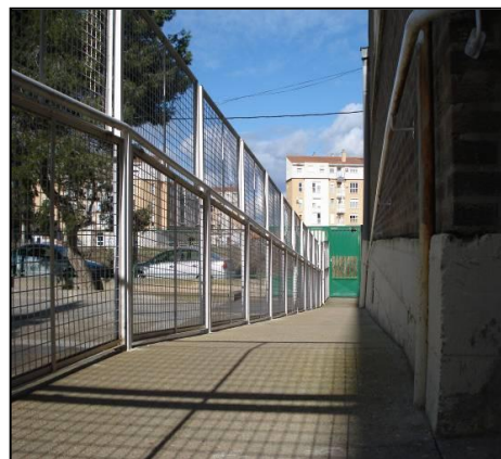
Rampa con barandillas a ambos lados. CEIP Alfonso X El Sabio, SAN ADRIÁN
