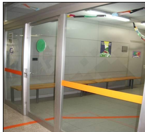
Señalización de la puerta y del suelo de entrada a un aula. CPEE Andrés Muñoz Garde. PAMPLONA
