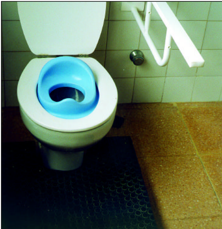
Reposapiés adaptado para el inodoro. Está cubierto con material de goma lavable y antideslizante.
